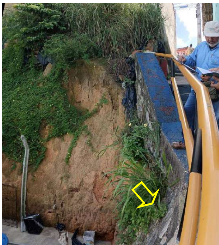
Figura 5.6.- Vista da região da escadaria, observa-se a implantação de pilares para ampliação das edificações, à direita, alvenaria de pedra serve para sustentar a escada e acesso mostrada na Figura 5.3.
