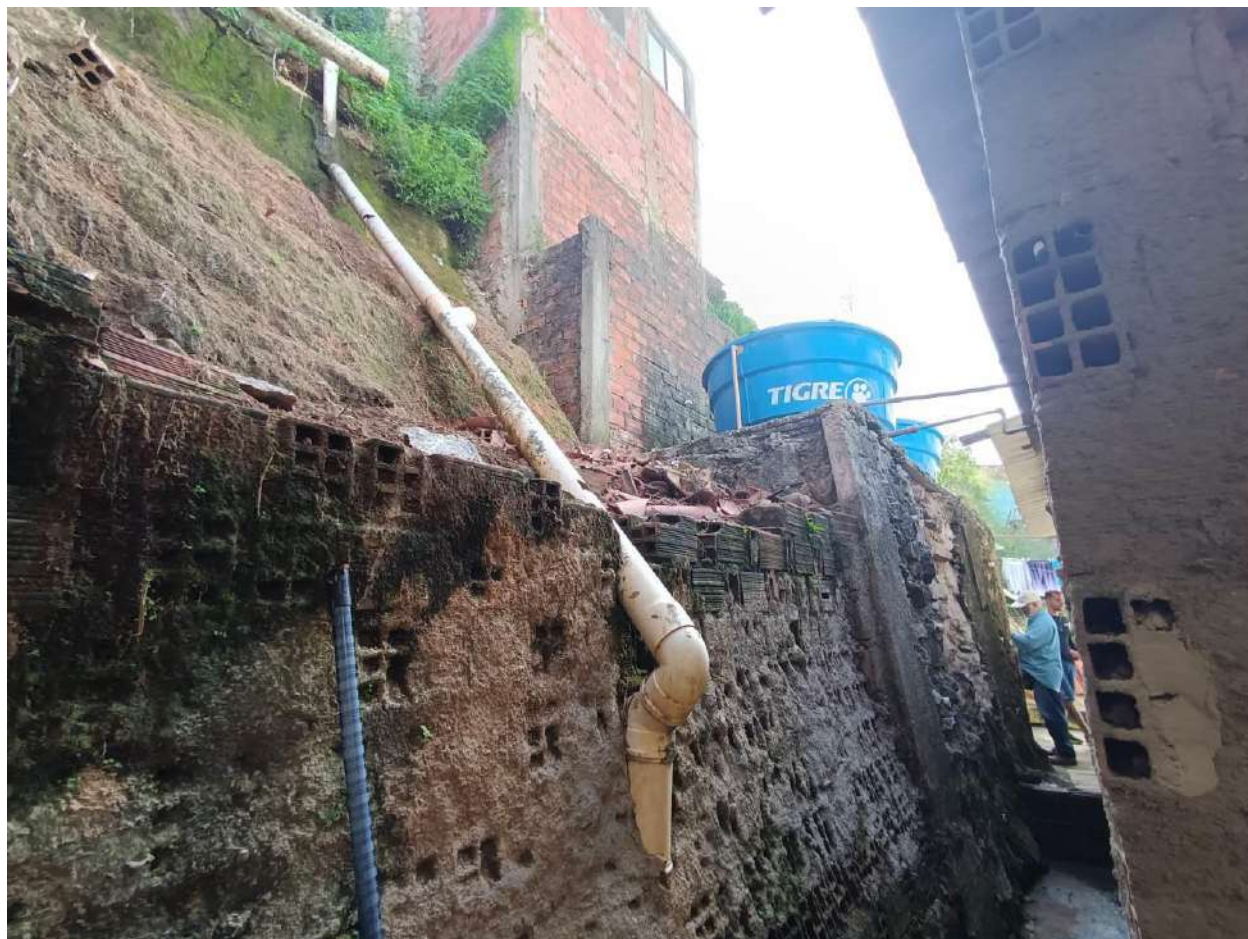
Figura 5.7 - Foto da área a esquerda (vista frontal) do talude, observa-se a presença de tubulação existente na meia encosta e contenção de bloco furado em péssimas condições presente no pé do talude.
