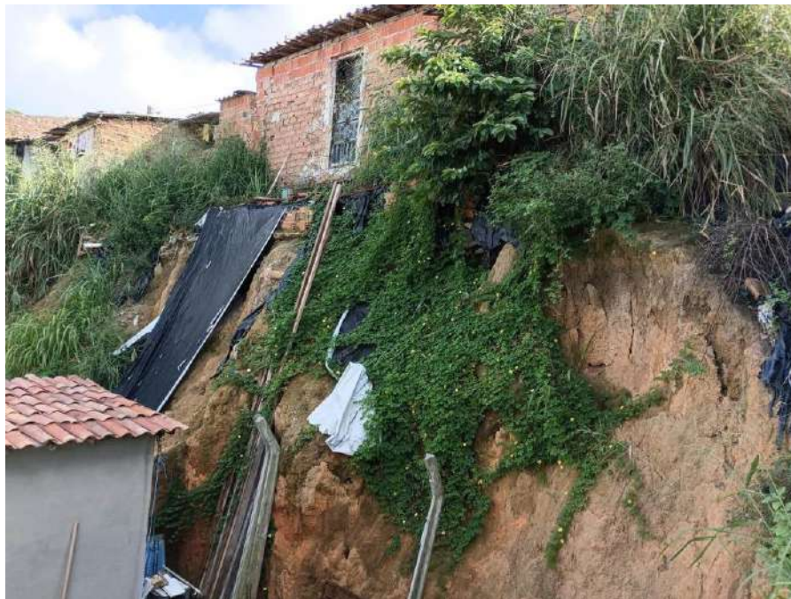
Figura 5.5 Vista da crista do talude onde observa-se a implantação das edificações na crista e cicatrizes de escorregamento com formação de taludes negativos.
